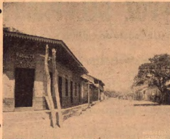
En Filadelfia de Guanacaste hasta las casas tienen aspecto de ruina. A esta casa hasta le tuvieron que poner pies de amigo para sostenerla. — ¿Qué les pasa filadelfinos?.
